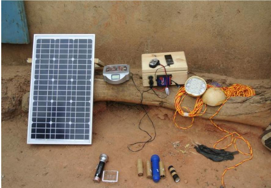
Diese Anlage sollte für eine Familie mit 20 Personen ausreichen, um den jetzigen Einwegbatteriebedarf zu ersetzen. Der Bauer in Guenghin wurde in die Funktion und Bedienung eingewiesen. Bisher läuft die Anlage problemlos. Die Refinanzierung erfolgt über monatliche Ratenzahlungen von 9,- € bei 12 Raten, bzw. 4,50 € bei 24 Raten. Im November 2013 werden weitere dezentrale Ladestationen gebaut und als Testobjekte eingesetzt.
